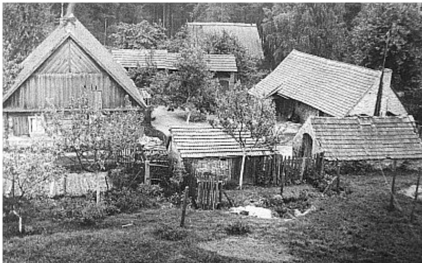
Windmühlenwohnhaus [SLUB, Deutsch Fotothek, Günter Rapp, Reproduktion nach einem alten Foto aus den 20er Jahren]
